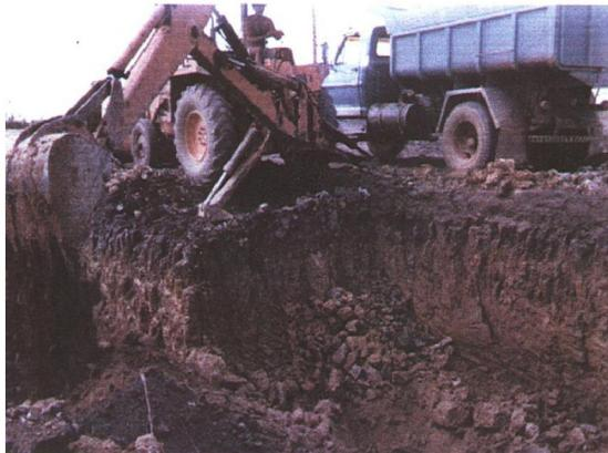
**Figura 2.4 – Exploração típica de uma jazida (Ramos, 2000).**
