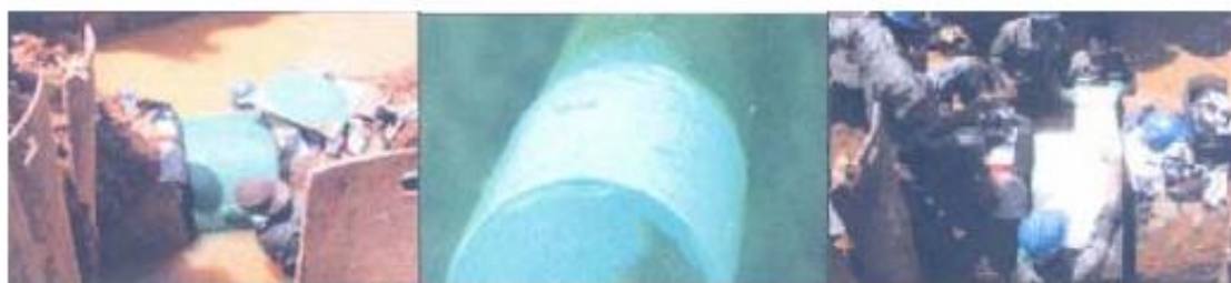
Figura 1.2: Imagem representativa da realização do reparo em ambiente aquático (Costa, 2010).
