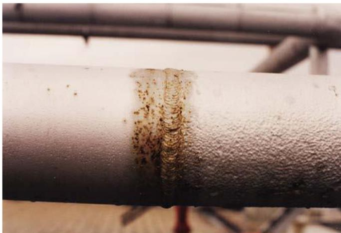
Figura 2.14 - Corrosão em componentes tubulares nas proximidades de solda (Gentil, 2003 apud Arruda, 2009).
