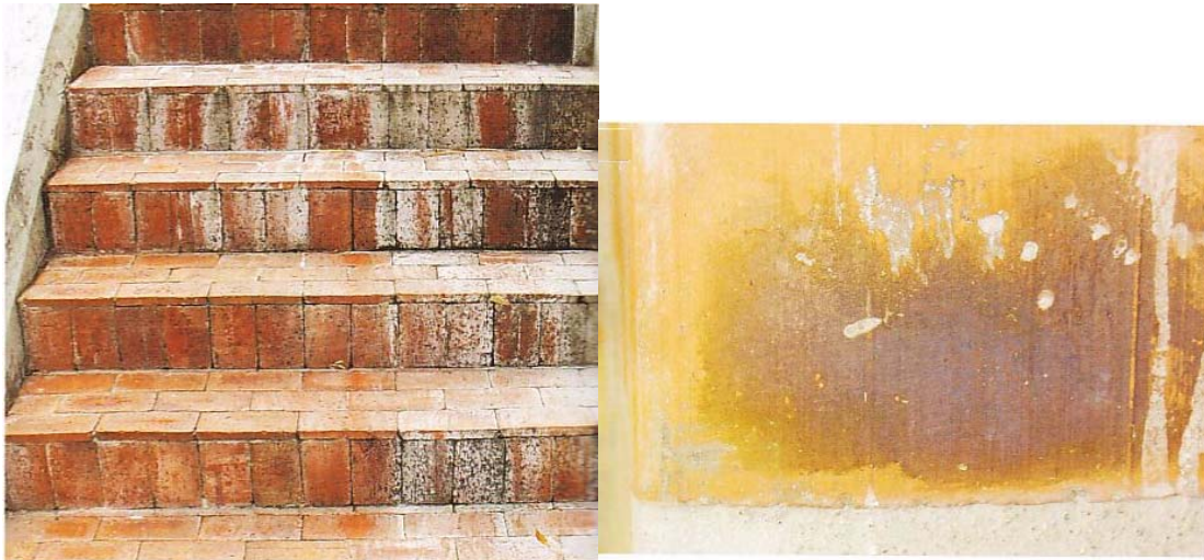
Figura 17: Eflorescências originadas por: a) Carbonato de Cálcio ( \text{CaCO}_3 ) e b) matéria orgânica.
