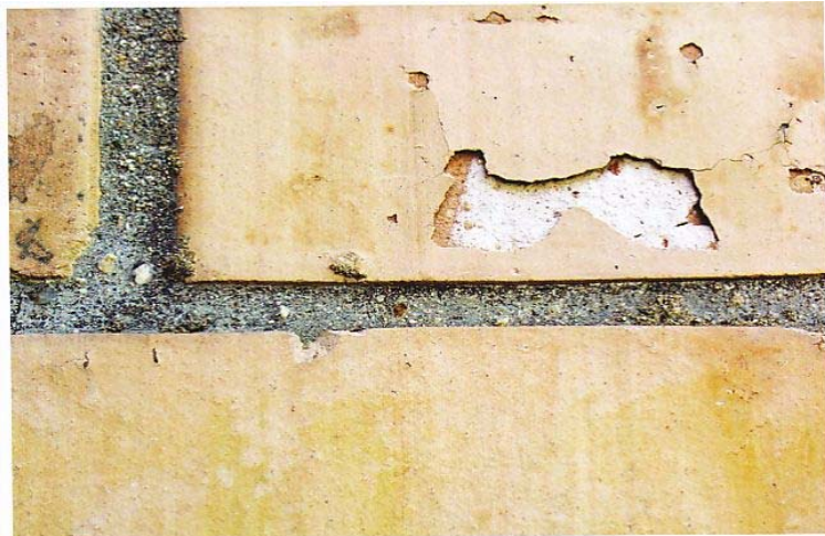
Figura 16: Eflorescência causada por Sulfato de sódio ( \text{Na}_2\text{SO}_4 \cdot n\text{H}_2\text{O} )
