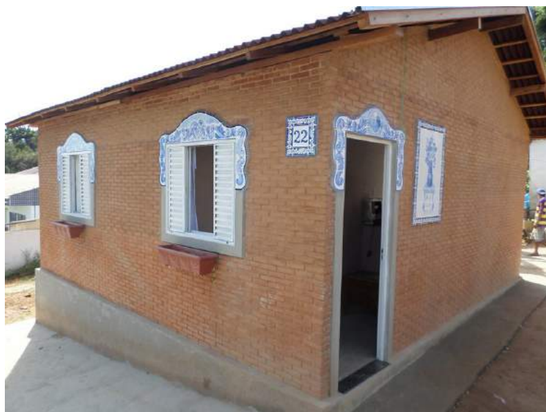
Figura 2.13 – Casa construída com solo - cimento na cidade de Cambuquira – MG. (Disponível em http://www.cambuquira.net/ , 2014).
