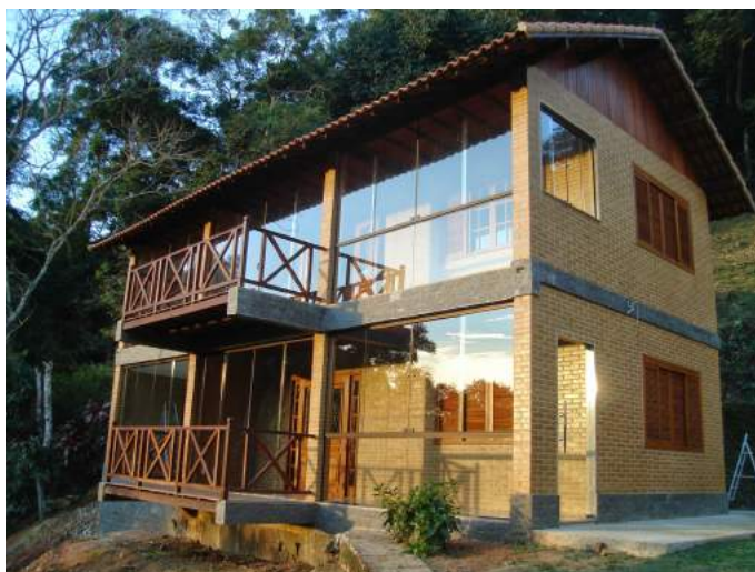
Figura 2.12 – Construção com solo-cimento (Maireles, 2014).
