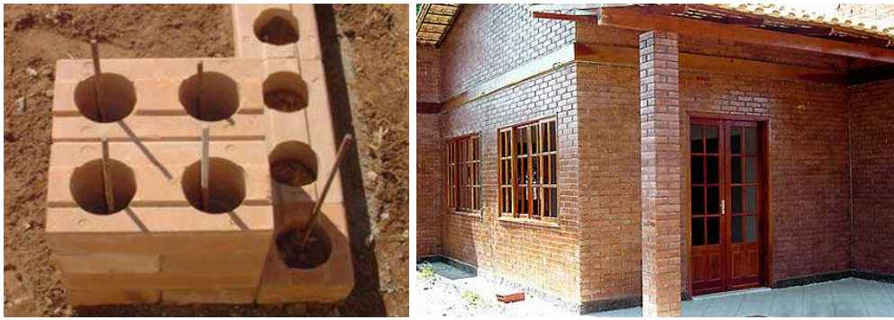
Figura 2.8 – Tijolo solo-cimento formando coluna.
