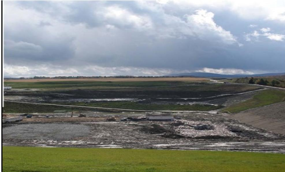
Figura 4.15- Área de aterro de resíduos industriais de compostos com enxofre (Estabrooks, 2013).
