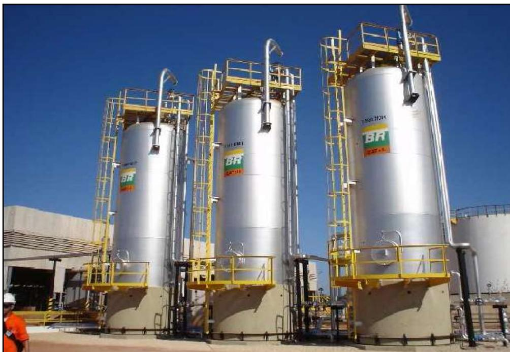
Figura 4.4- Unidade de remoção de gases ácidos da PETROBRAS (Lopes, 2003).
