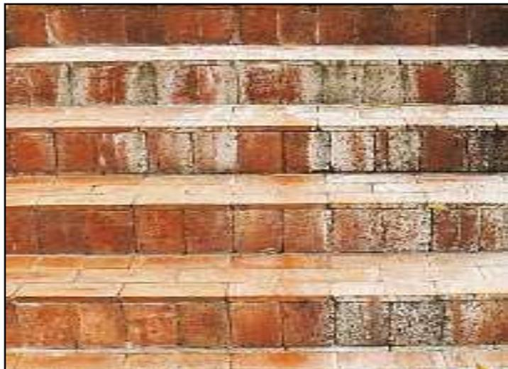
Figura 4.18- Eflorescência provocada por carbonatos de cálcio em cerâmica (Verdusch, 2000).
