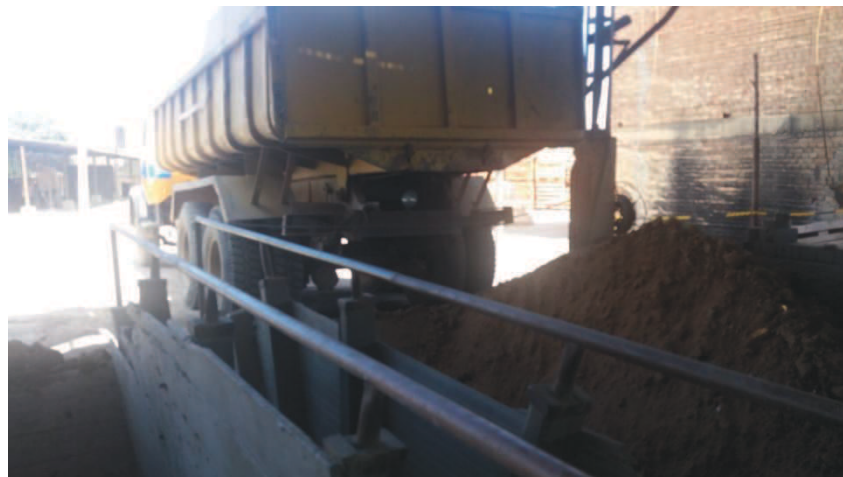
Figura 4.20: O material depositado no caixão para ser desintegrado e misturado.
