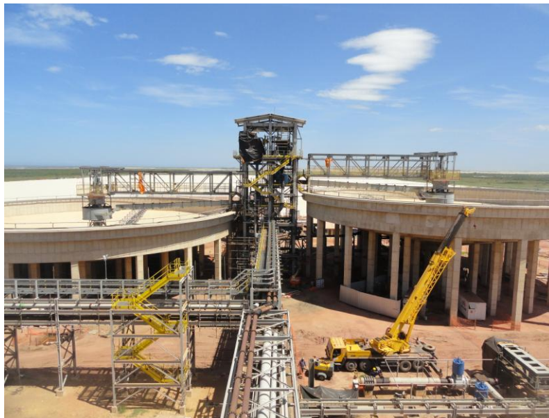
Figura 23. Clarificador, à esquerda da foto, e Espessador, à direita da foto. Planta de Filtragem, Sistema Minas-Rio (foto de visita em campo do autor).
