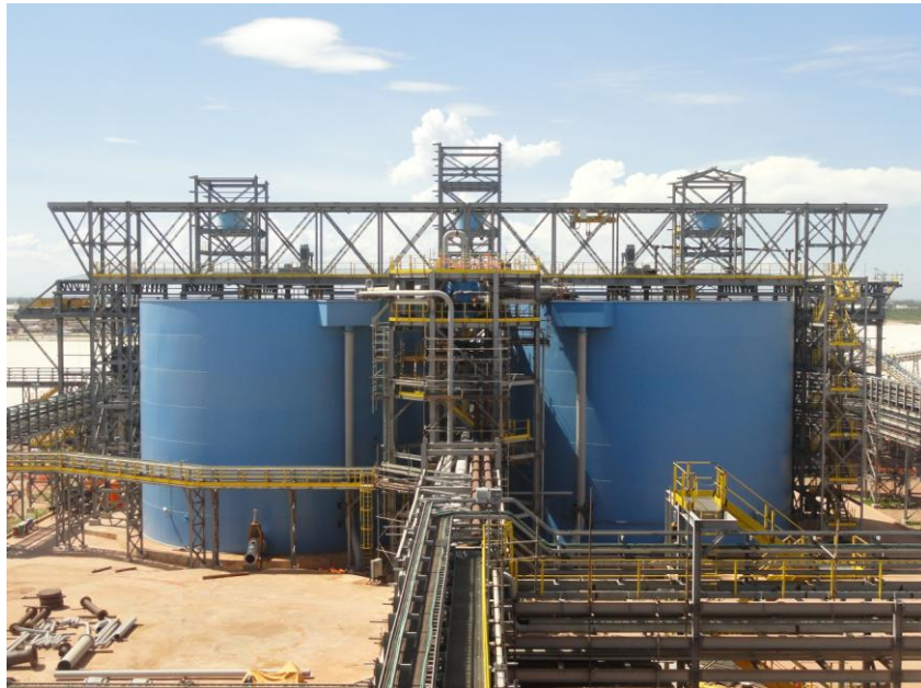
Figura 24. Tanques de homogeneização. Planta de Filtragem, Sistema Minas-Rio (foto de visita em campo do autor).
