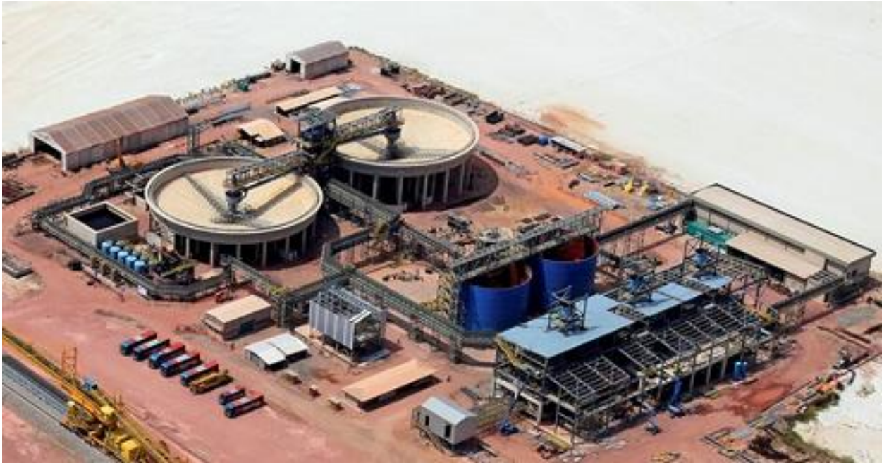
Figura 26. Vista aérea mais recente da fase de obras da Planta de Filtragem da Anglo American.
