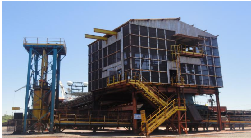
Figura 32. Torre de Transferência enclausurada (foto de visita em campo do autor).
