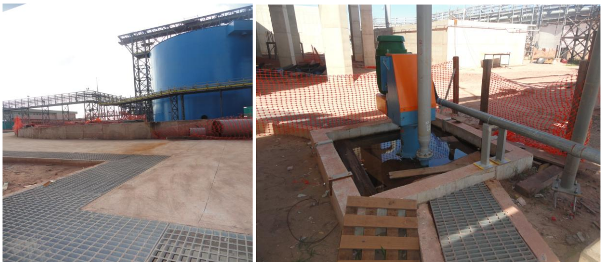
Figura 25. Canaletas (grades no chão) para recolhimento de efluentes (à esquerda) e Caixa coletora de efluentes e detalhe da bomba para drenagem ao Clarificador (à direita). Planta de Filtragem, Sistema Minas-Rio (foto de visita em campo do autor).
