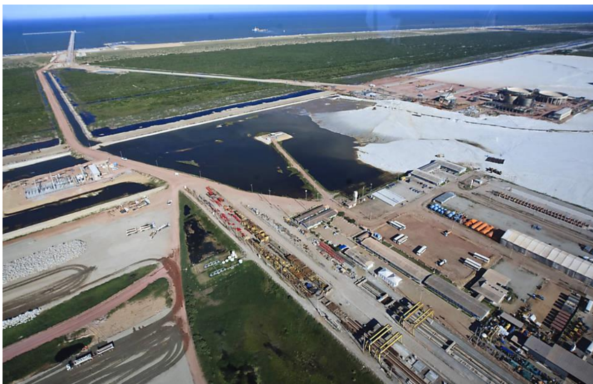
Figura 7- Obras de construção do Porto do Açu Fonte: Folha de São Paulo
