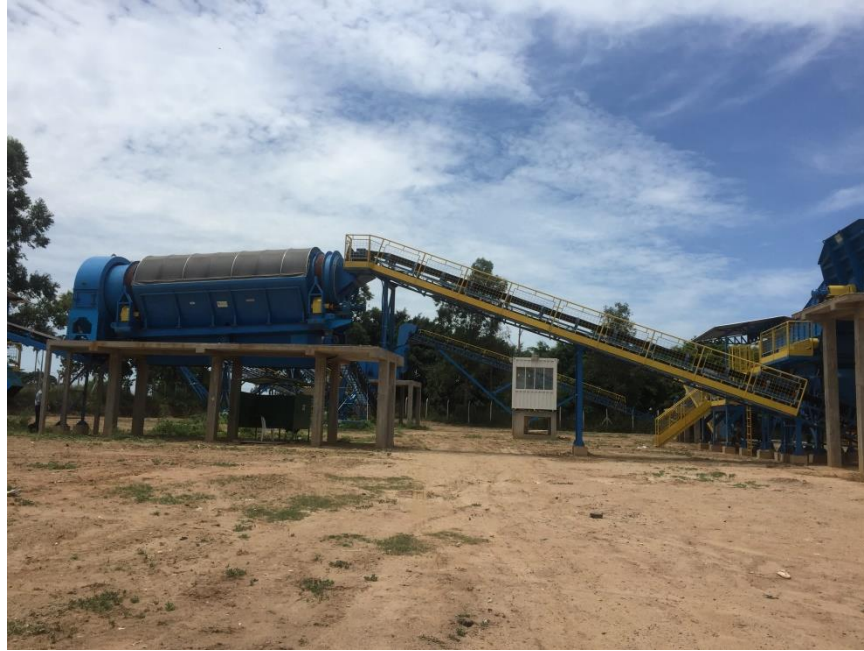
Figura 40 - Estrutura da futura usina de reciclagem de RCC no aterro de inertes da CODIN – Fevereiro de 2016.
