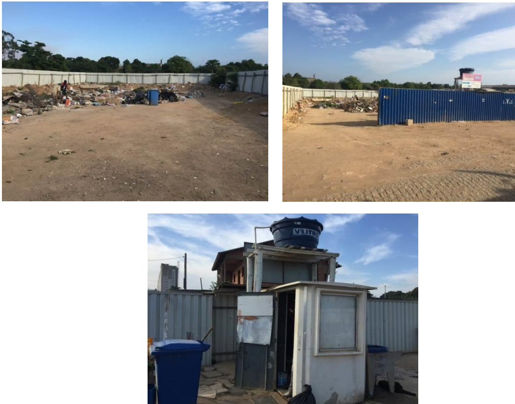
Figura 37 - Estrutura do PEVE localizado no bairro Salo Brand.
