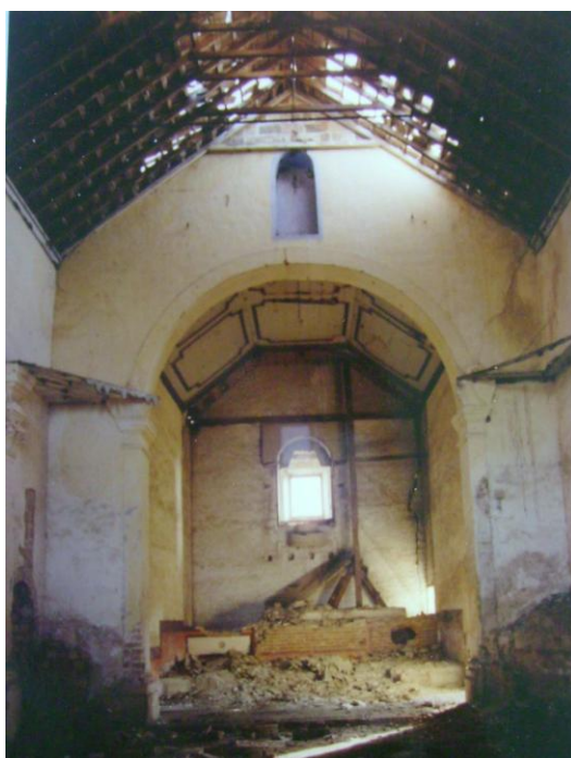
Figura 4: Imagem do Interior da Capela (FENORTE, 1990)
