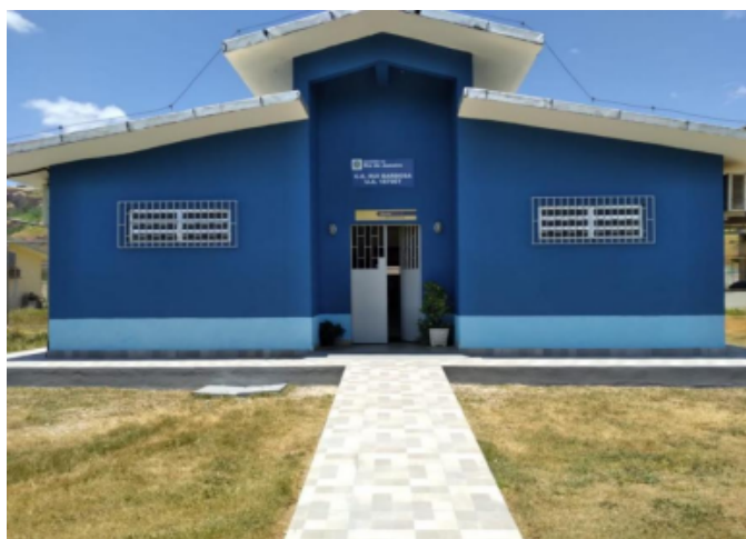
Figura 09: Fachada da escola que recebeu nova pintura. 4/02/21
