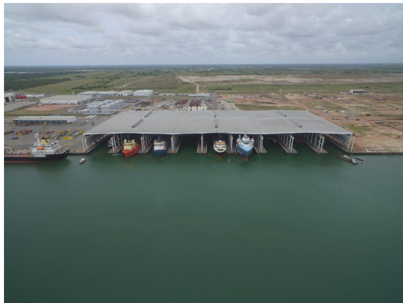
Figura 37- Baias Cobertas B-Port
