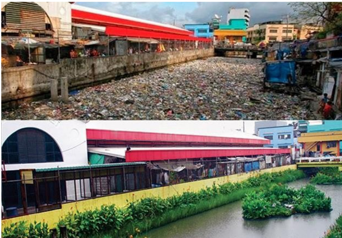
FIGURA 2: Fotografia de um mesmo rio localizado no Canal Paco, em Manila, na Filipinas. Em A observa-se o rio com alto índice de poluição afetando o aspecto visual e as espécies que ali viviam. Em B observa-se Ilhas artificiais ecológicas modulares capazes de acelerar a recuperação natural do rio. Fonte – Hyneness (2015).
