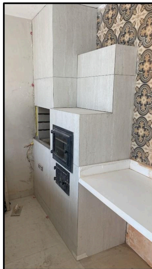
Figura 4 – Projeto executado. (Fonte: Figura cedida pela Elevar Construtora).
