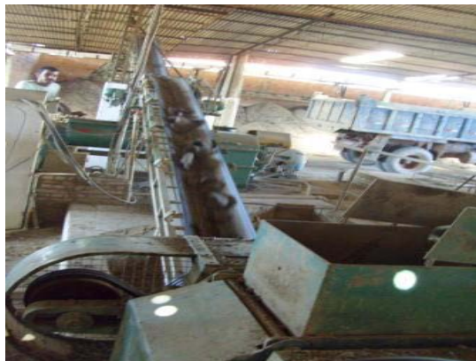
Figura 10 - Esteira transporte laminador p/ extrusora
