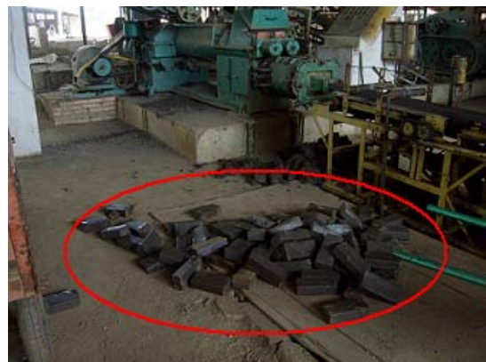
Figura 34 - Detalhe tijolos maciços cortados com problemas
