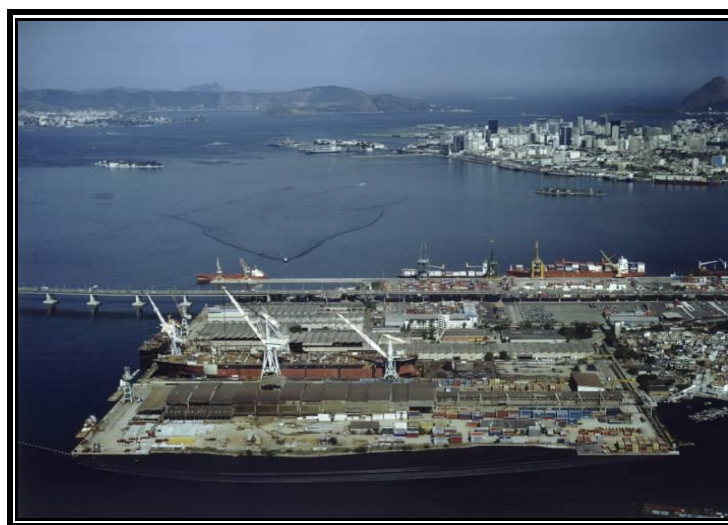
Figura 15 – Área do Porto utilizado pela empresa no Rio de Janeiro. Vista lateral
