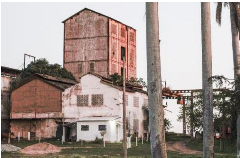
Figura 2 – Ruínas da Usina de Queimados
