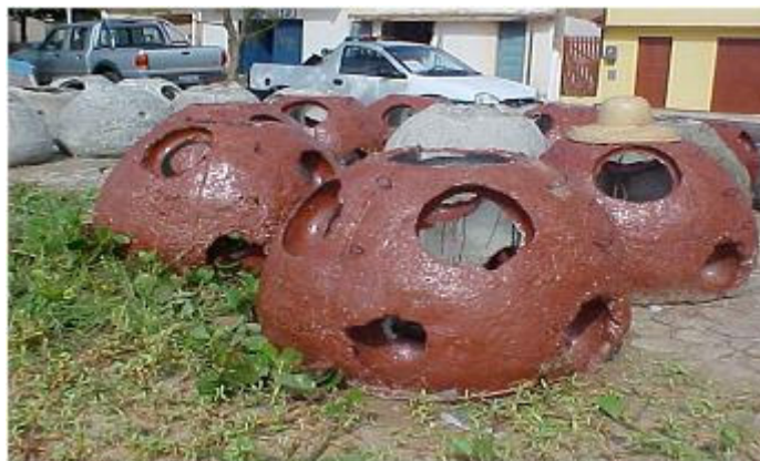
Figura 3: Foto dos módulos constituintes do complexo de recifes artificiais marinhos.
