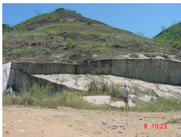
Figura 43: Detalhe da frente de lavra abandonada devido a ocorrência de fratura e juntas de alívio, além de mesclas de materiais diversos. Pedreira Itereré – Localidade de Rio Preto em Campos dos Goytacazes.
