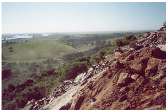
Figura 39: Vista da encosta onde os rejeitos da extração de blocos são depositados. Pedreira Itereré – Campos dos Goytacazes
