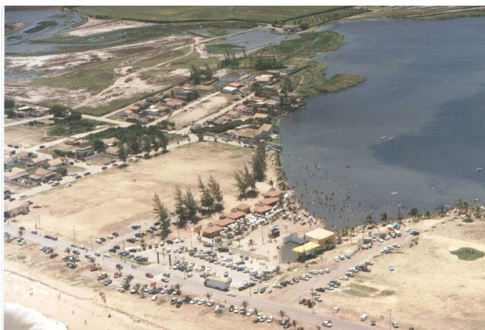
Figura 58: Vista ampla do sistema de lagoas Lagamar comprometido pelo uso inadequado. Lagamar – Farol de São Tomé – Campos dos Goytacazes. (maio de 2002)
