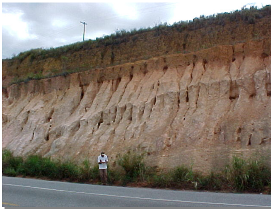
Figura 54: Perfil de solo típico encontrado no domínio colinoso, solo podzólico, declividade de 20% 40%. – BR-101. Localidade Serrinha – Município de Campos dos Goytacazes.
