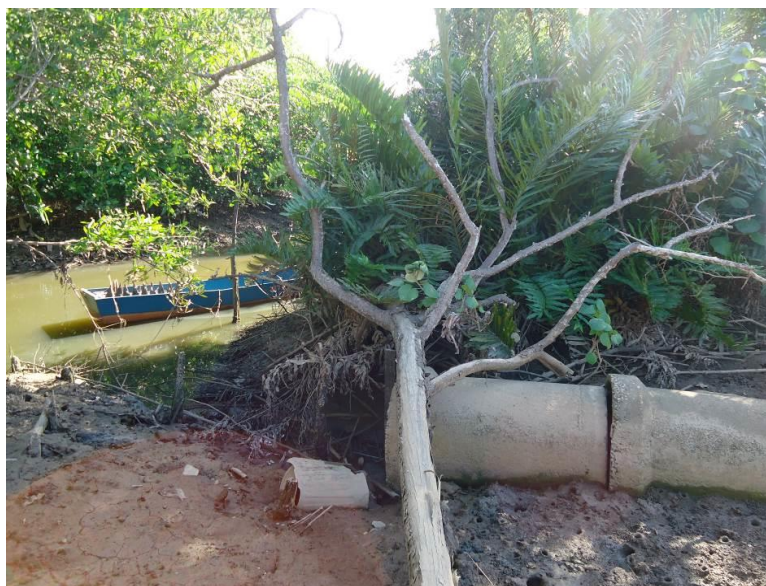
Figura 4. Canal de manilhas utilizado para lançamento de efluentes domésticos, construído pela Prefeitura Municipal de São Francisco de Itabapoana na comunidade de Gargaú, norte do estado do Rio de Janeiro, sudeste do Brasil. Foto: Laura Côrtes.
