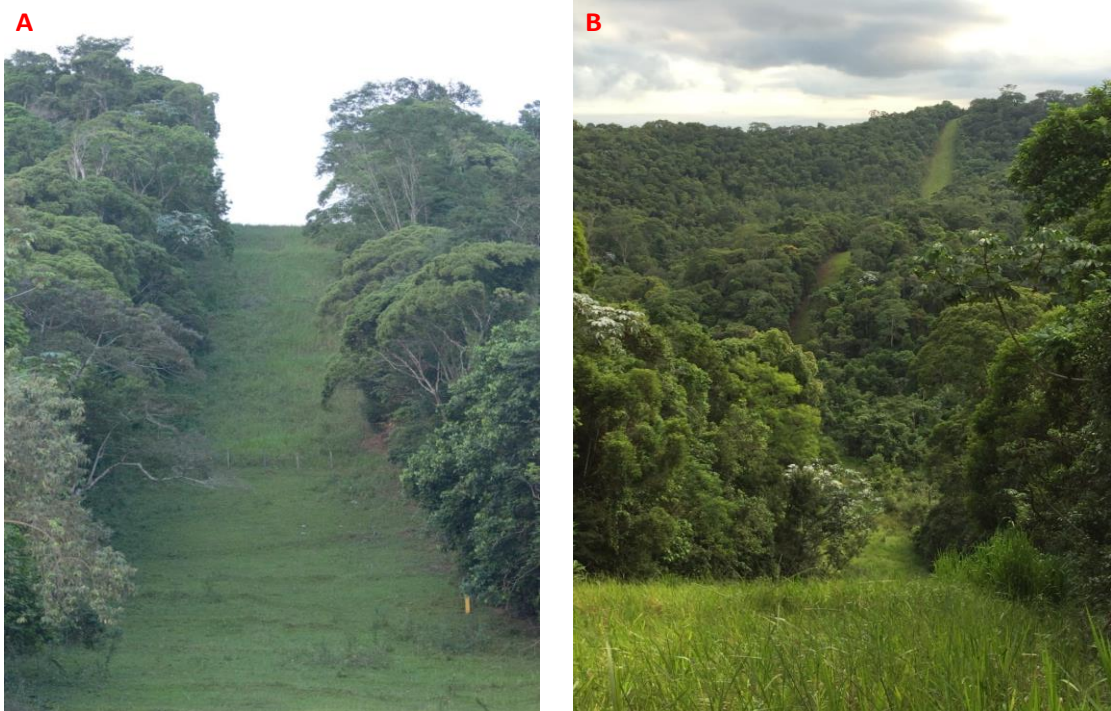
Figura 6 - Foto de um trecho do tratamento borda do gasoduto (GA) na REBIO União, RJ. Fonte: A – B; Reis, B.N (2018).
