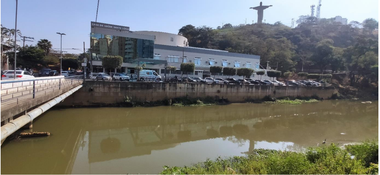
Figura 13: Região da Casa de Saúde em Muriaé-MG, evidenciando ocupação desordenada das margens do Rio Muriaé e descarte de efluentes nos cursos d'água. Fonte: Fotografia do próprio autor, 2021.
