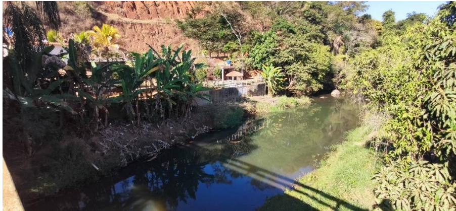
Ocupação das margens do rio Muriaé, evidenciando erosão das encostas. Fonte: Fotografia do próprio autor, 2021.
