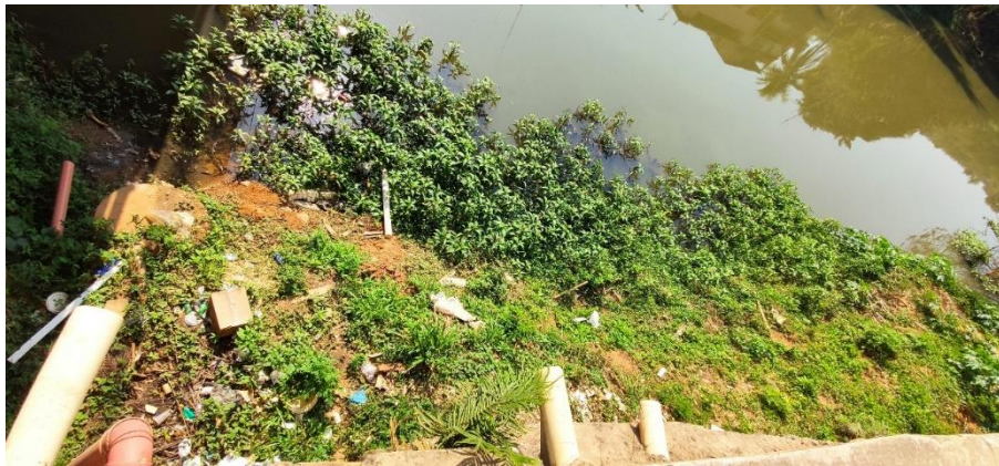
Fotografia realizada da ponte do Porto em 12 de agosto de 2021 evidenciando descarte inadequado de resíduos e presença de tubulações para descarte de efluentes nos cursos d'água.
