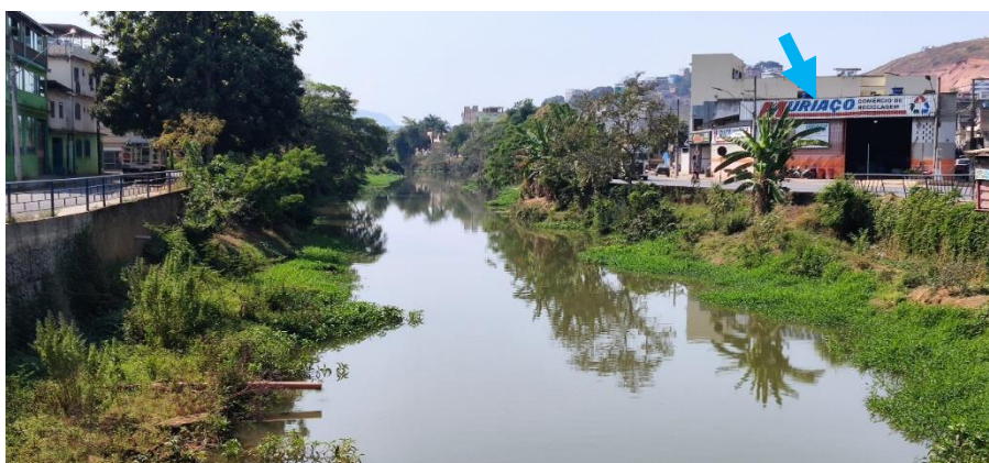
Fotografia realizada da ponte do Napoleão em 12 de agosto de 2021, evidenciando ocupação das margens do rio, ausência de mata ciliar e presença de tubulação para descarte de efluentes nos cursos d'água. Fonte: Fotografia do próprio autor, 2021.
