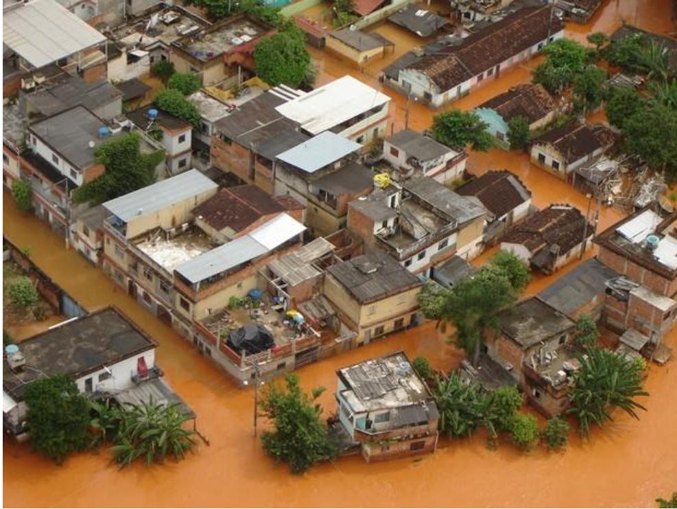
Figura 9: Inundação em Muriaé proveniente do Rompimento da Barragem São Francisco em janeiro de 2007.
