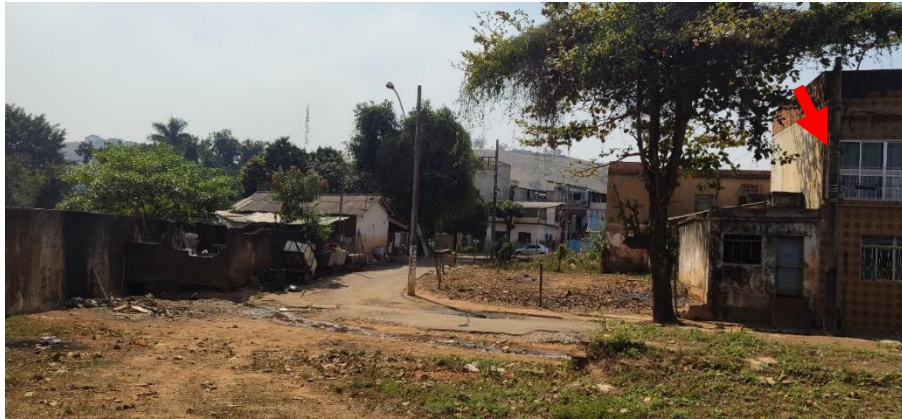
Fotografia realizada na região da Prainha em 12 de agosto de 2021 evidenciando o abandono de imóveis e descarte de entulhos na região de entorno do rio Muriaé
