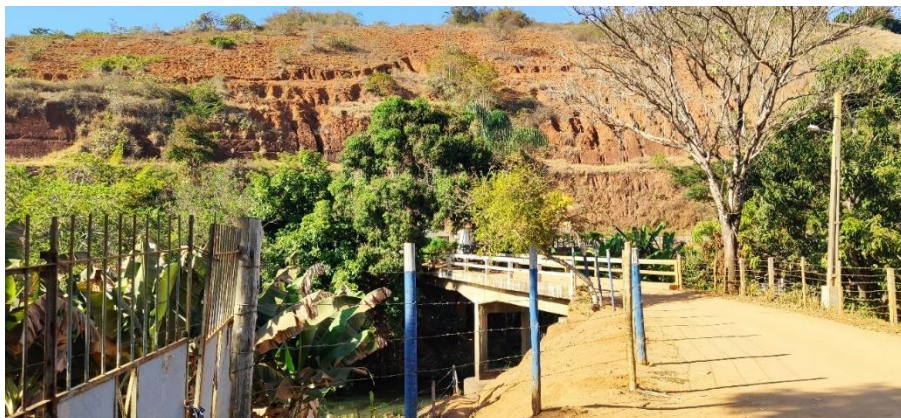
Ocupação das margens do rio Muriaé para fins agrícolas, evidenciando erosão das encostas e ausência de mata ciliar.
