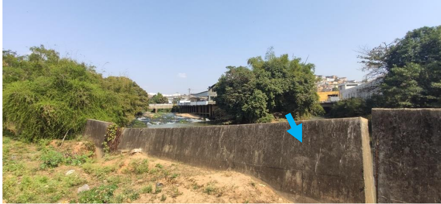
Fotografia realizada na região da Prainha em 12 de agosto de 2021 evidenciando o muro de contenção de enchentes erguido neste local.
