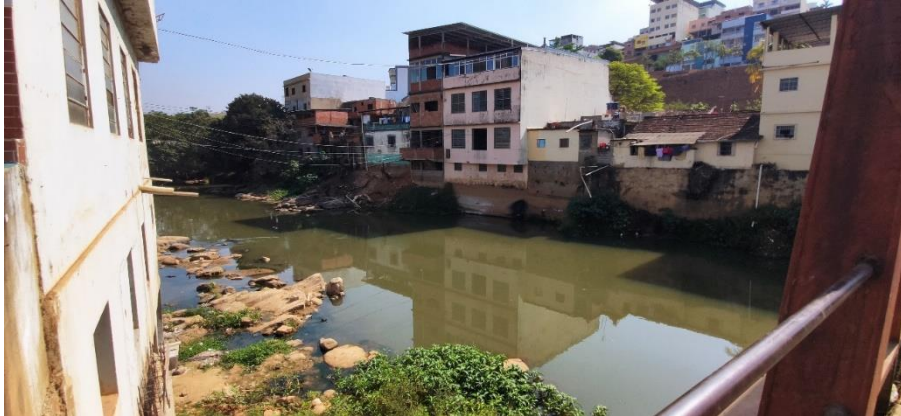
Fotografia realizada da ponte do Porto em 12 de agosto de 2021 evidenciando ocupação das margens do rio, ausência de mata ciliar, presença de tubulações para descarte de efluentes nos cursos d'água.
