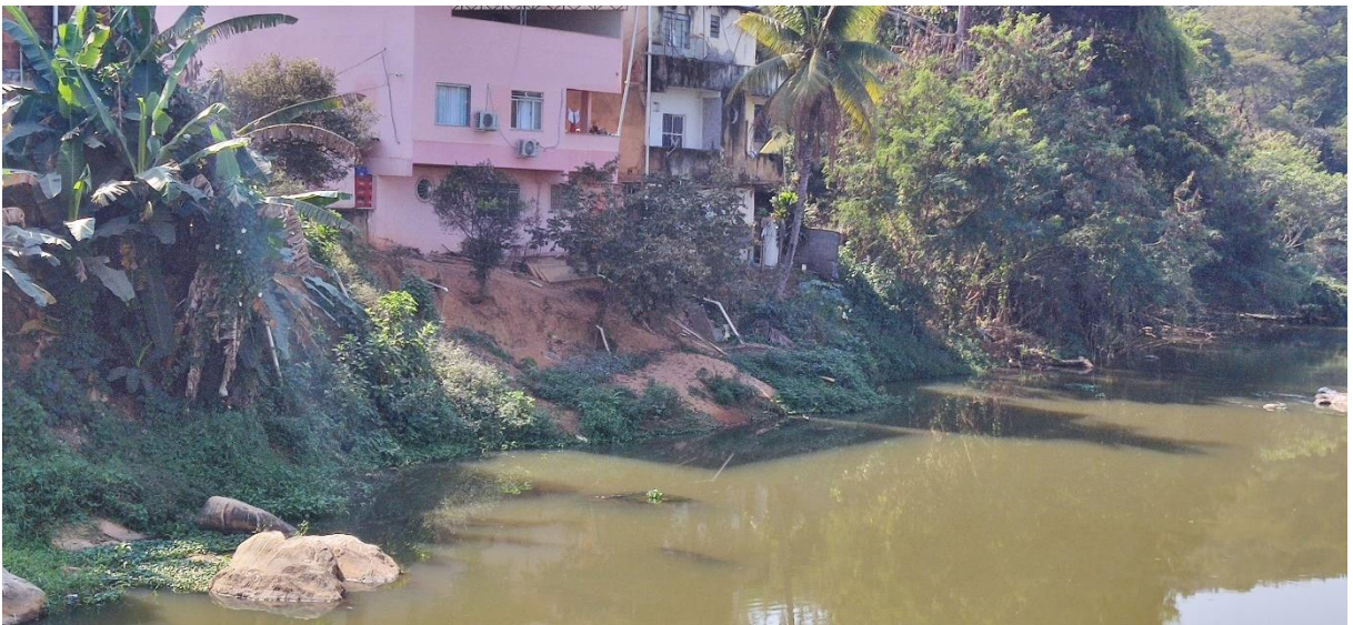
Figura 16: Fotografia realizada de cima da ponte do bairro do Porto em Muriaé-MG, evidenciando ocupação desordenada das margens do rio e o descarte de efluentes residenciais nos cursos d'água do Rio Muriaé.
