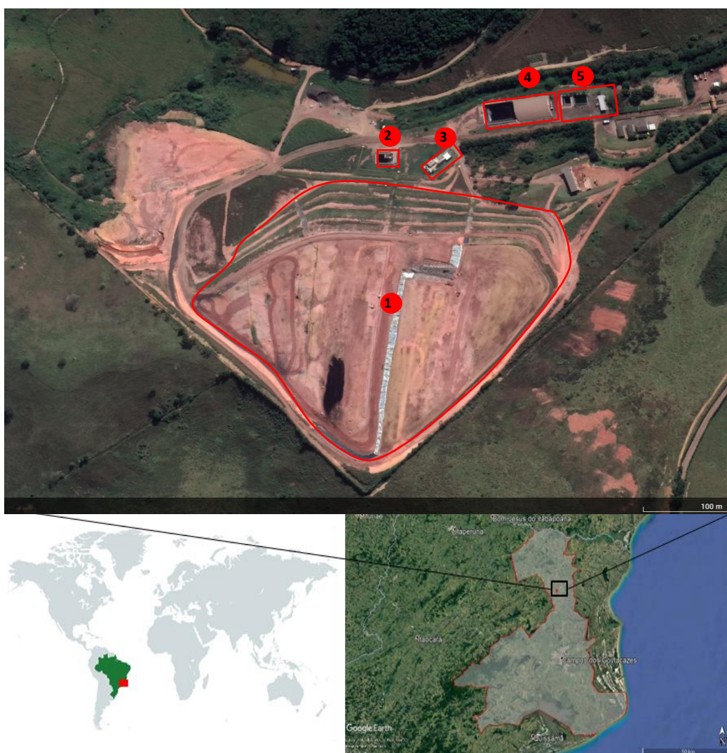
Figura 1 Localização da Central de Tratamento de Resíduos (CTR – Campos), no subdistrito de Conselheiro Josino de Campos dos Goytacazes – RJ. Adaptado de (Geaquinto, 2018). 1 – Aterro Sanitário; 2 – Tanque de Recebimento de Chorume; 3 – Usina de Biogás; 4 – Tanque de Acúmulo e Evaporação de Chorume; 5 – Estação de Tratamento de Efluentes.
