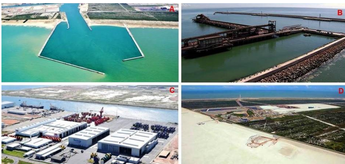
Figura 1 - Instalações e construções do Porto do Açú: A) Terminais TX2; B) Quebra-mar no TX1; C) Empresas instaladas ao longo do CN; D) Aterro hidráulico construído perto da área de restinga. Fonte: Prefeitura Municipal de São João da Barra (2019).
