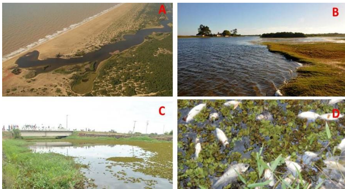
Figura 11 - Corpos hídricos no 5 o Distrito próximos ao Porto do Açú: A) Parte inicial da LDI, onde ocorre abertura da barra; B) Margem da LDI; C) CQ próximo à localidade de Água Preta; D) Mortandade de peixes ocorrida no CQ em 2013. Fonte: Prefeitura Municipal de São João da Barra (2019).
