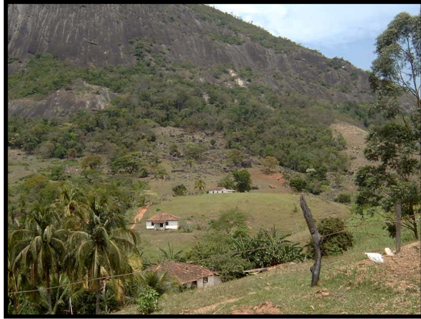
Foto 43: Depósito de Tálus/Colúvio na Serra da Pedra Lisa. Urbanização em local inadequado.
