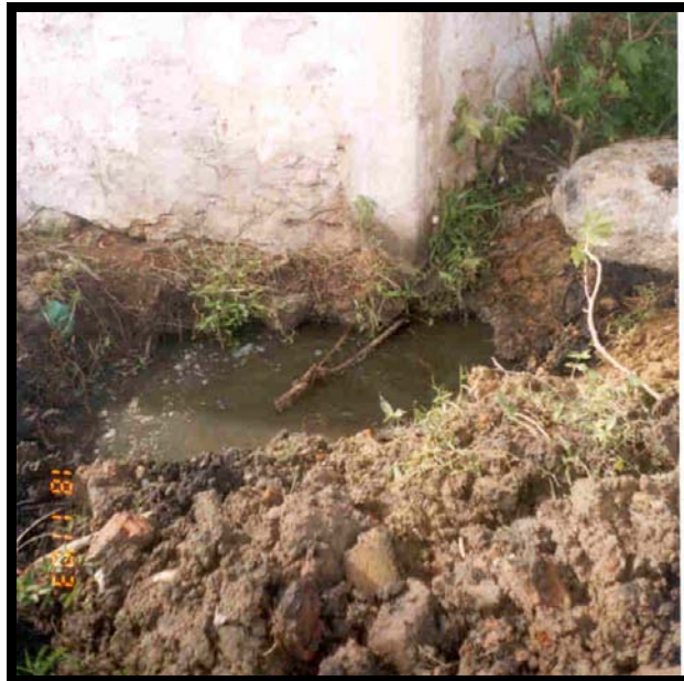
Foto 31: Execução de obra em Campos, lençol freático aflorante (Foto cedida pelo Engenheiro Mário Barroso).
