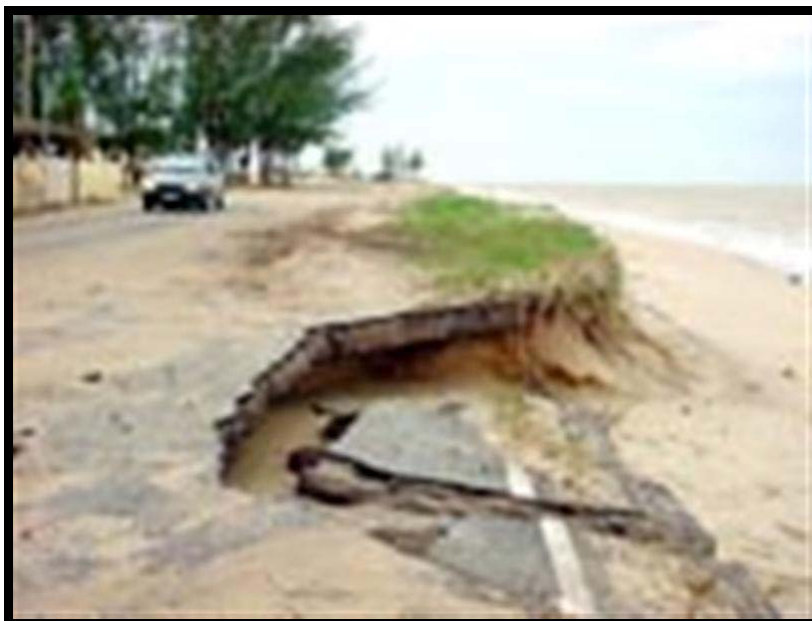
Foto 52: Trecho da orla marítima da praia de Farol de São Tomé, em novembro de 2004, atingida pela erosão marinha (Fonte: Jornal "Monitor Campista").
