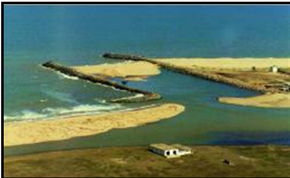
Foto 53: Foz do Canal das Flechas: Mole construído sem o estudo das correntes marinhas (de um lado erosão, do outro deposição) resultando no fechamento do canal (Fonte: SEMADS, 2002).
