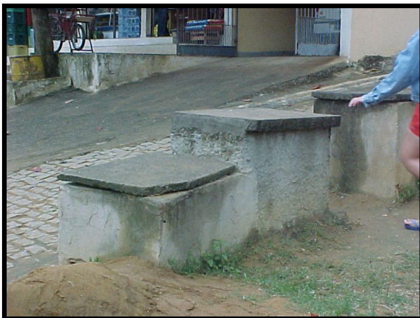
Foto 33: Poços Tubulares em Morro do Coco no meio da calçada. A água é bombeada e jogada para as casas que se encontram em cima do morro.
