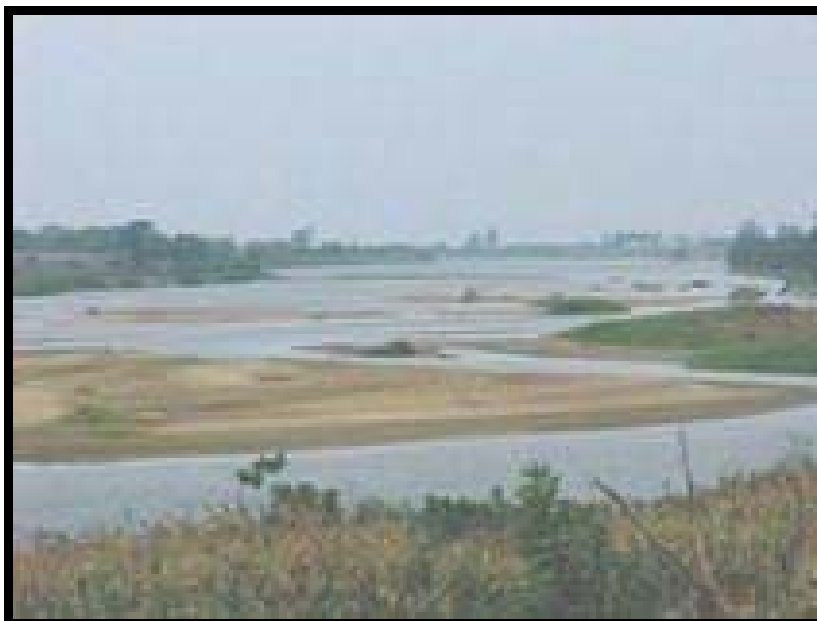
Foto 63: Assoreamento no leito do Rio Paraíba do Sul em Campos (Fonte: Puget e Nunes, 2000).
