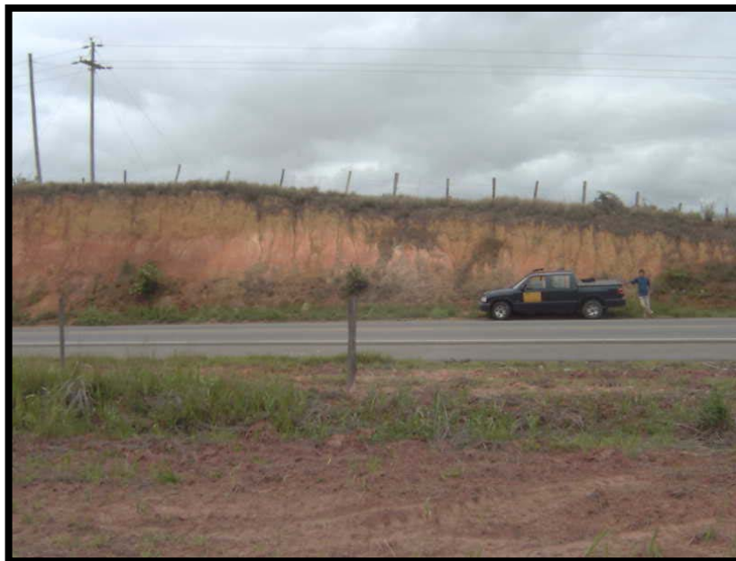
Foto 40: Colúvio com Solo Residual na BR 101, em direção ao Rio de Janeiro.
