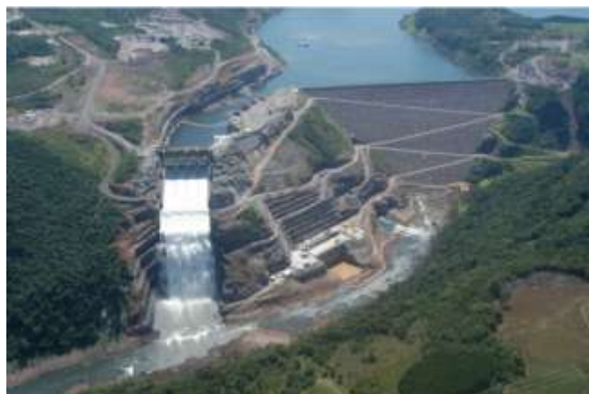
Figura 1.1: Enrocamento com face de concreto - Barragem de Campos Novos
