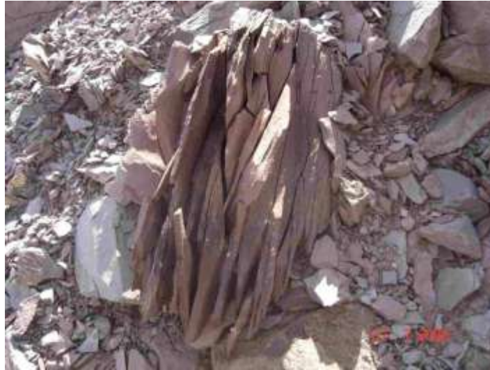
Figura 4.22: Enrocamento da Barragem de Manso
