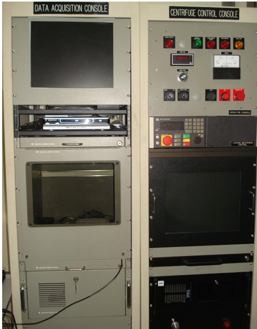
Figura 3.10 – Consoles de controle e aquisição de dados da centrífuga geotécnica.
