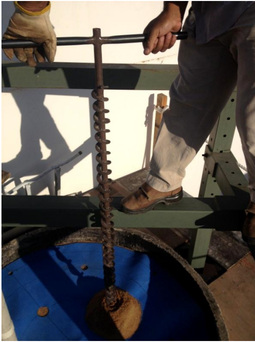
(a) Início da escavação
