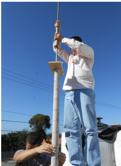
(c) Início da cravação
