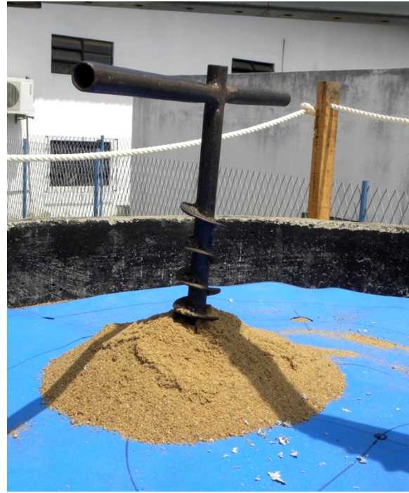
(b) Fim da escavação
