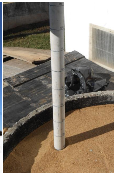
(d) Cravação da estaca
