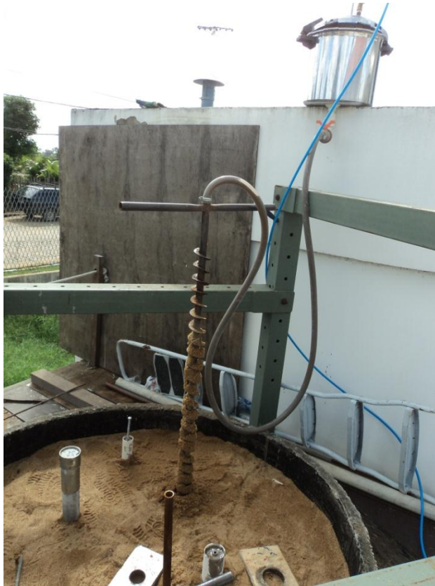
Figura 3.21: Procedimento para concretagem das estacas hélice contínua
