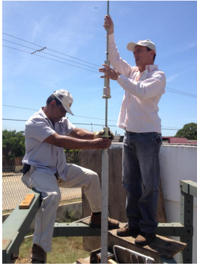
Figura 3.14: Procedimento de cravação da estaca de 6cm de diâmetro no tanque com areia densa
