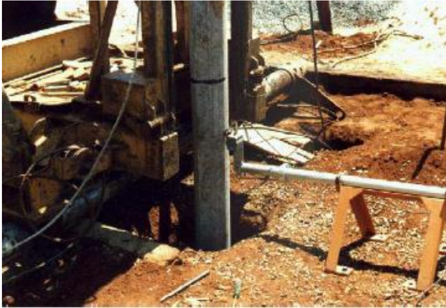
Figura 2.3: Cravação de estaca pré-moldada
