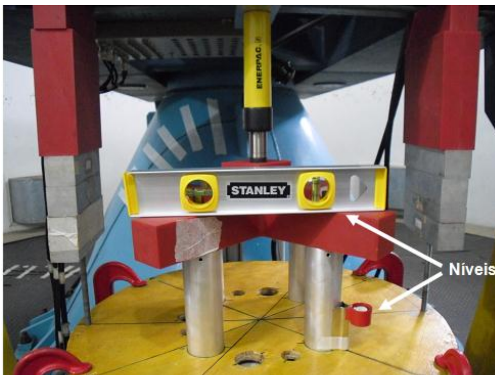
Figura 4.26–Controle de verticalidade das estacas.
