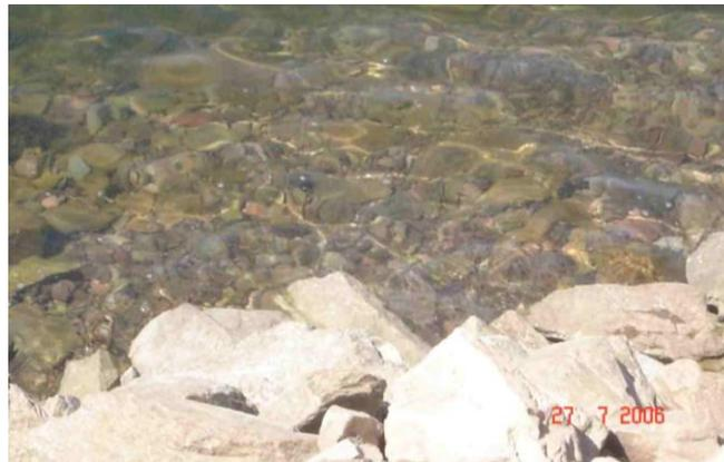
Figura 4.7: Enrocamento abaixo do nível mínimo do reservatório da Barragem de Manso.
