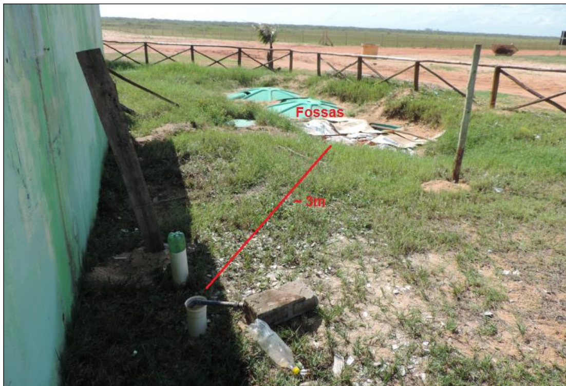
Figura 6-5 - Fossas instaladas a poucos metros do poço P43.
