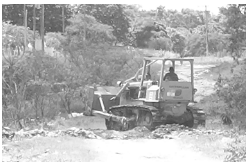
Figura 5.5 Reabertura do vertedouro (mar/06)
