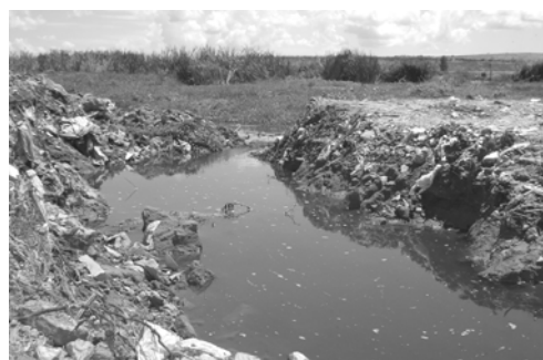
Figura 5.6 Detalhe do vertedouro (mar/06)
