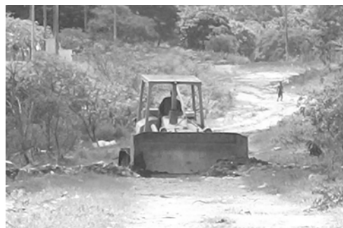
Figura 5.4 Fechamento do vertedouro (dez/05)
