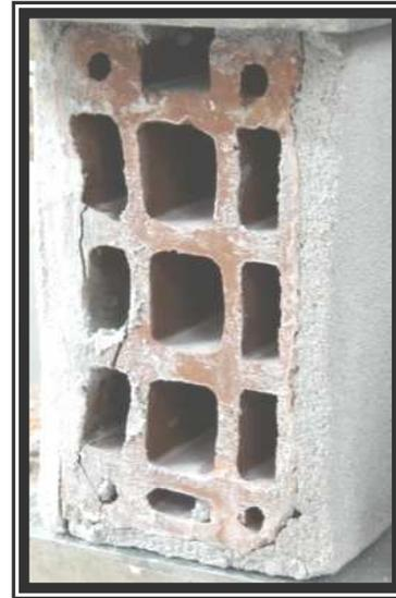
Figura 5.9 - Aumento na abertura das fissuras
