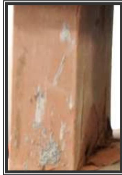
Figura 5.13 - Pequena variação das fissuras e a deformação de parte do bloco
