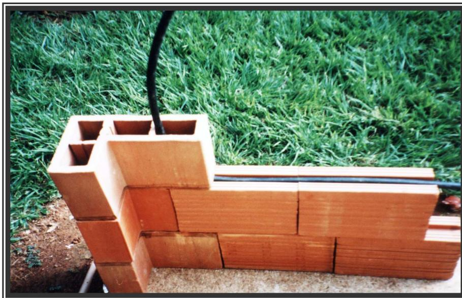
Figura 4.4 – Detalhe da subida do eletroduto
