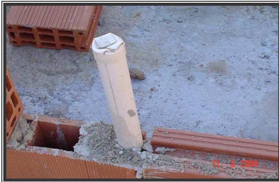
Figura 4.8 – Detalhe da tubulação de esgoto que receberá os despejos da pia
