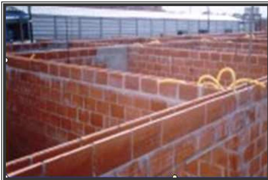
Figura 4.14 – Detalhe da utilização do bloco canaleta
