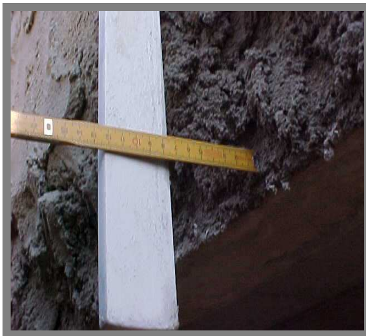
Figura 27 – Espessura de argamassa no revestimento da fachada - obra B
