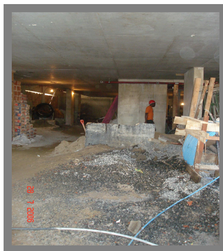
Figura 1 – Canteiro da obra C
