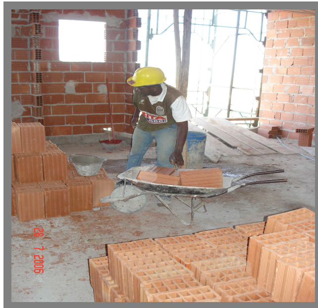
Figura 15 – Transporte de blocos cerâmicos em carrinhos de mão - obra C
