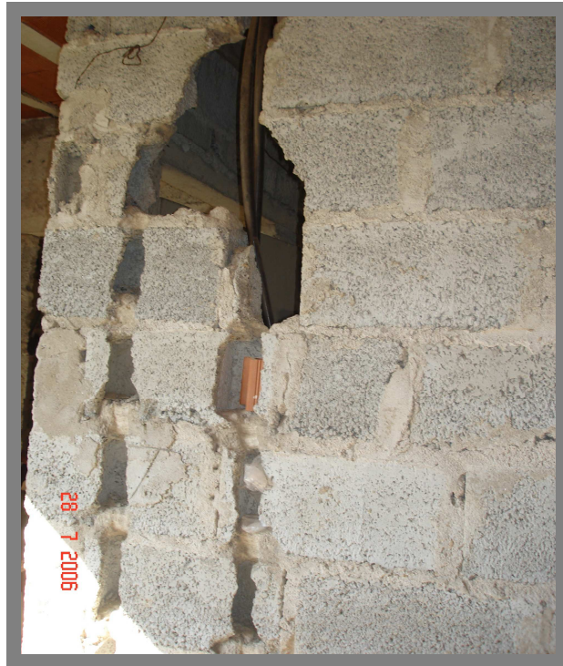
Figura 17 – Corte nos blocos de cimento para execução de instalações - obra E
