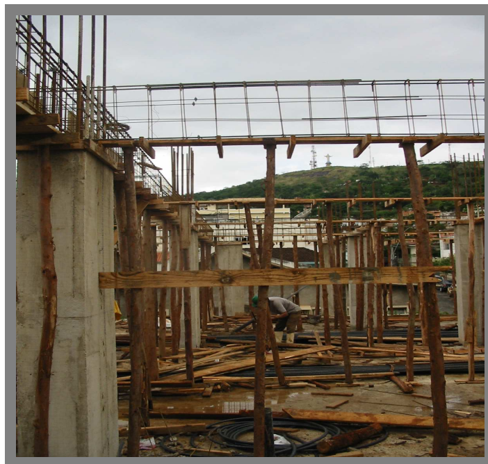
Figura 5 – Rejeitos de madeira após montagem de formas da obra D
