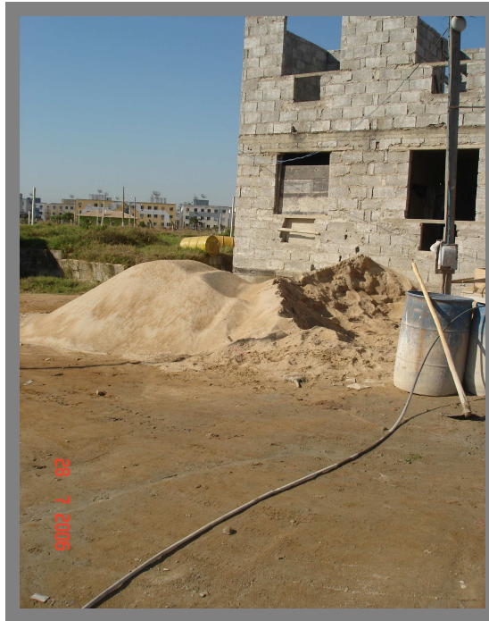
Figura 8 – Areia estocada ao ar livre - obra E
