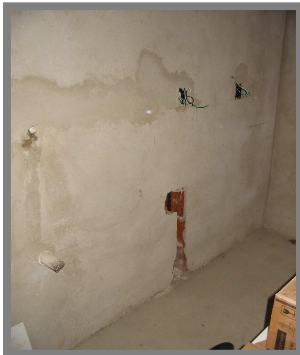
Figura 18 – Rasgos para instalações após parede argamassada
