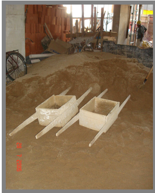
Figura 9 – Utilização de padiolas para transporte de areia na obra D
