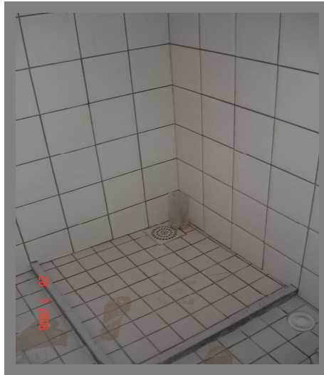
Figura 37 – Recortes no fechamento dos pisos - obra E
