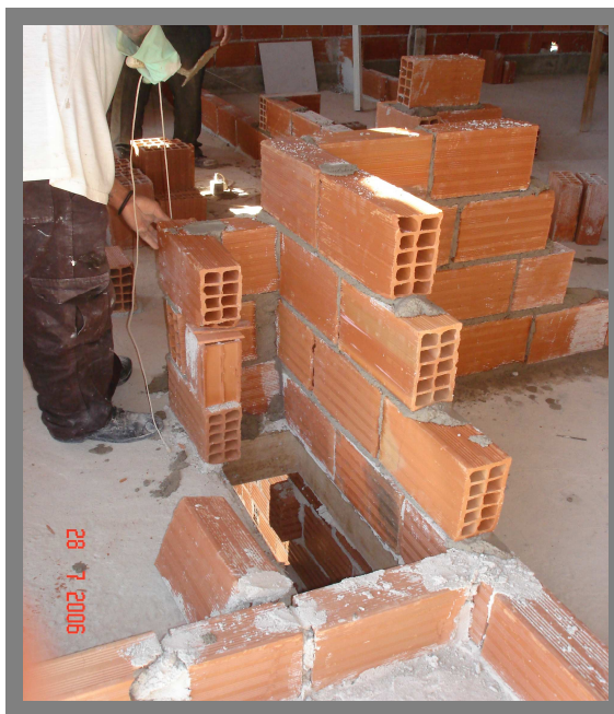
Figura 31 – Furo na laje para passagem de instalações - obra C
