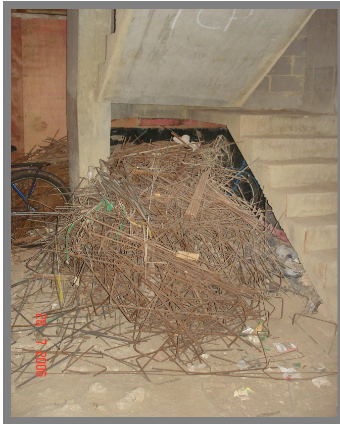
Figura 6 – Rejeitos de barras de aço, devido aos cortes sem planejamento (obra C)
