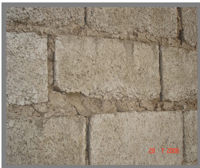
Figura 13 – Acabamento dos blocos estruturais - obra E
