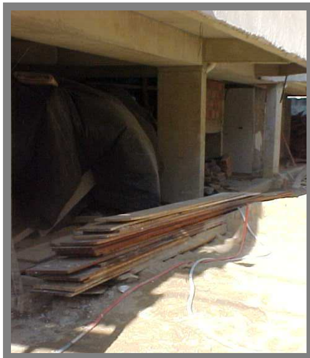
Figura 3 – Armazenamento de chapas de madeira ao ar livre da obra B
