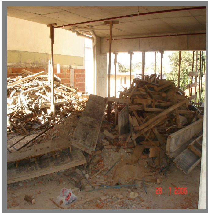
Figura 4 – Rejeitos de madeira após montagem de formas da obra C
