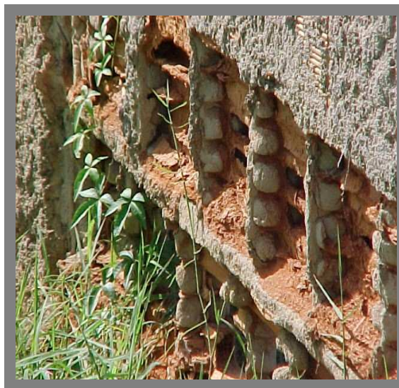
Figura 21 – Argamassa incorporada nos furos dos tijolos - obra E
