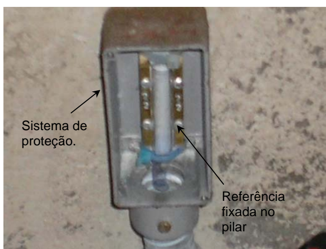
Figura 3.10 – Sistema de proteção da referência no pilar.
