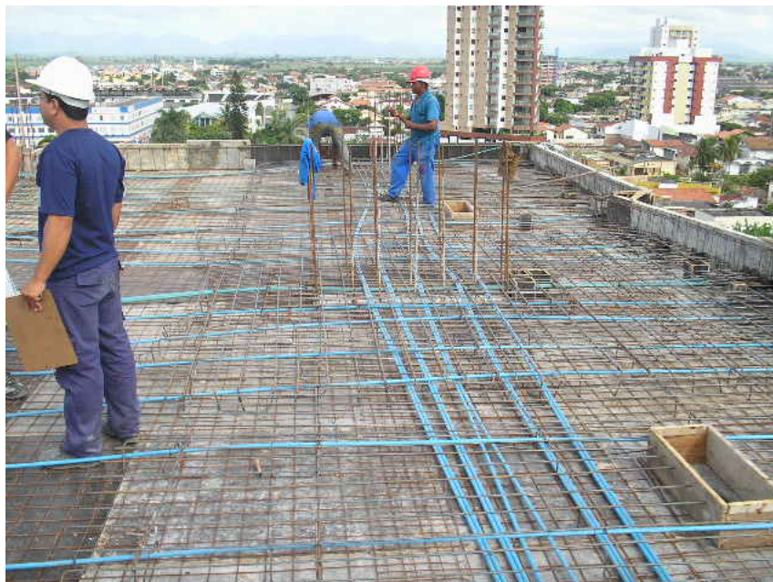
Figura 3.2 – Armadura da laje protendida com cordoalhas engraxadas.
