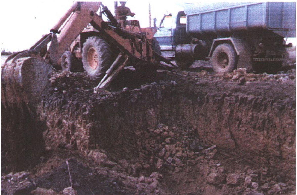
Figura 1.2 - Exploração típica de uma jazida
