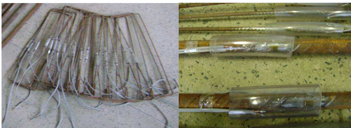
Figura 3.12 - Instrumentação da armadura transversal e longitudinal.
