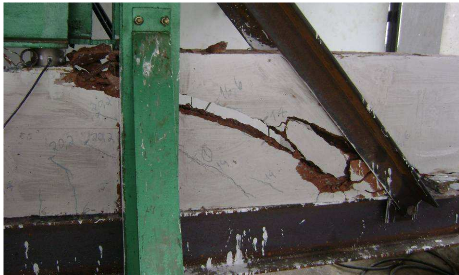
Figura 7.6 - Viga 3 após ruptura.
