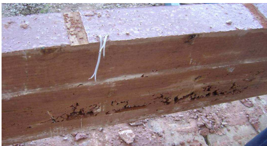
Figura 4.2 - Nichos de concretagem na Viga 2.
