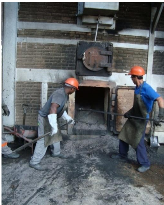
Figura 3.3 - Retirada da cinza do bagaço durante uma operação de limpeza na Usina Coagro (BARROSO, 2011).
