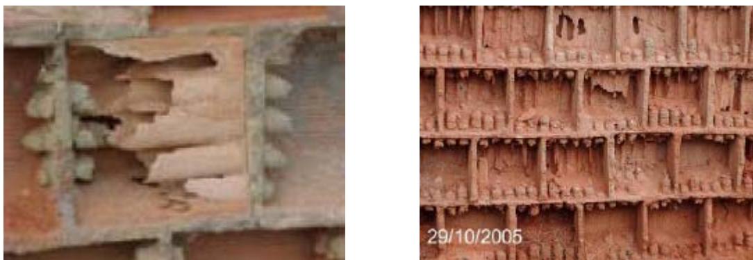
a) Degradação rápida em alvenaria em ambiente marinho – Grussaí-RJ b) Degradação rápida em alvenaria em ambiente marinho – Macaé-RJ
