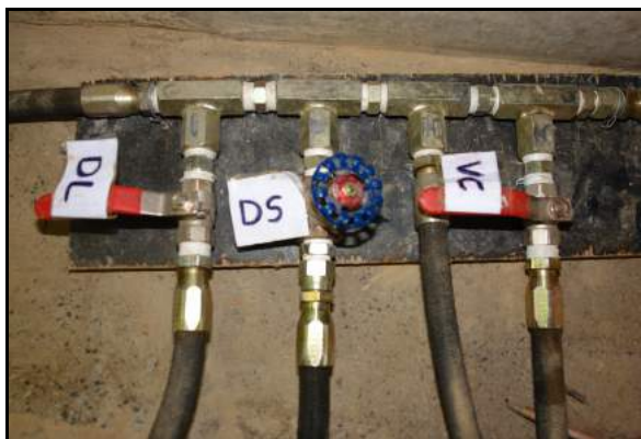
Figura 102 – Coletor drenante geral e detalhes da válvula agulha do dreno de saturação (DS), da válvula esfera do dreno ladrão (DL) e da válvula esfera da caixa (VC).
