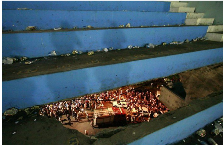
Figura 2 - Acidente na arquibancada do estádio da Fonte Nova, Bahia. (fonte: www.globo.com/oglobo )
