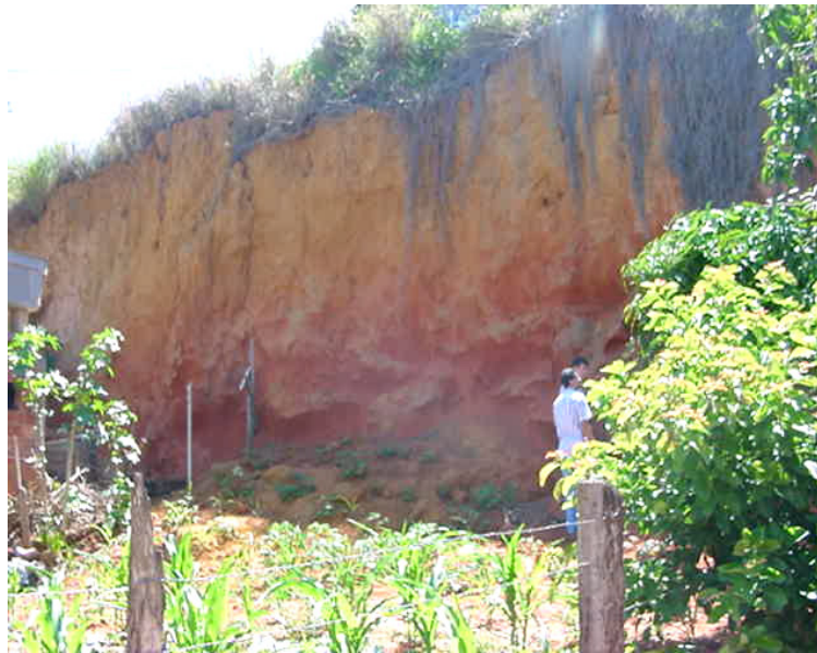
Figura 4.3 - Vista a jusante da área de estudo com ausência de vegetação.
