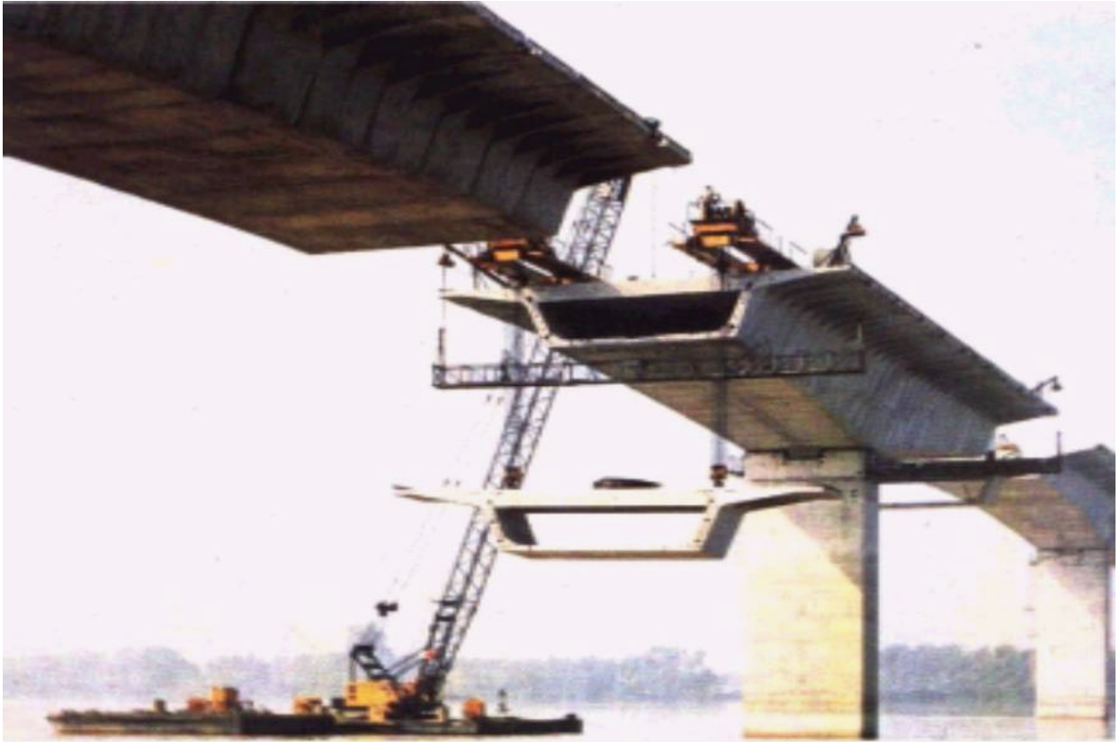
Fig. 5 - Ponte Rio-Niterói – (aduelas pré-fabricadas)
