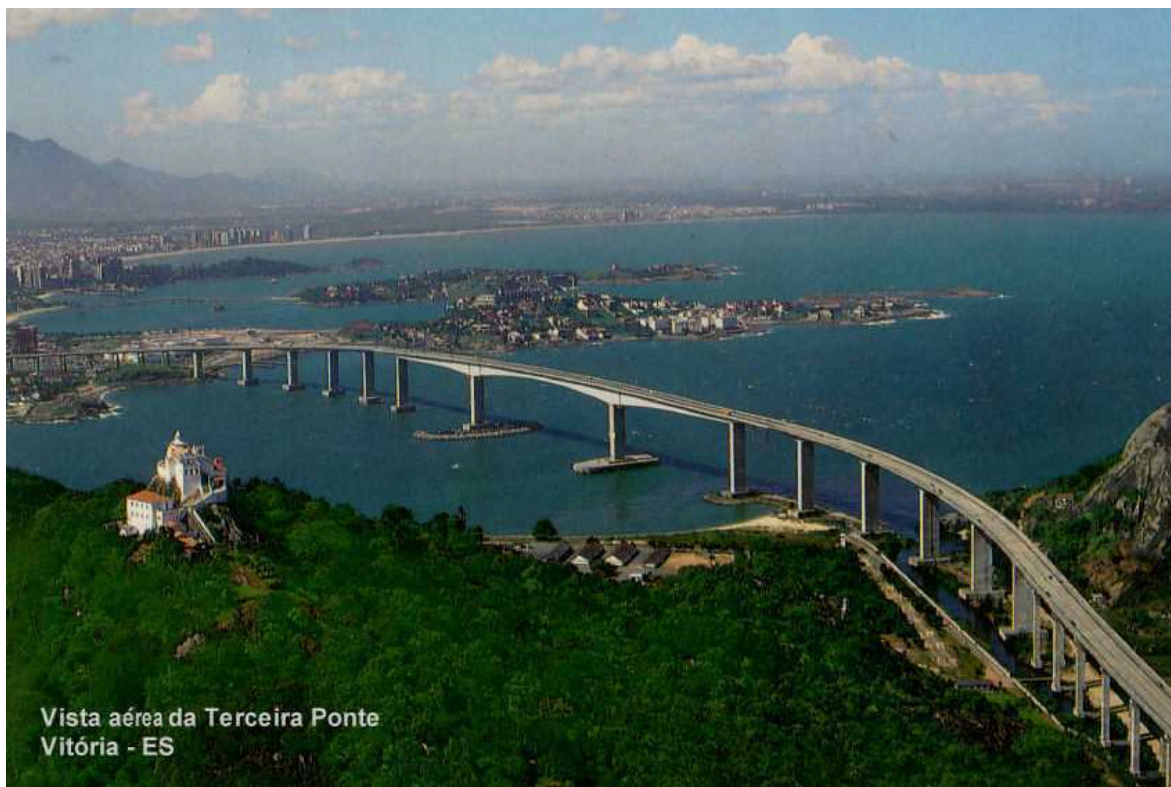
Figura 1 - Terceira Ponte. (É um das maiores pontes do Brasil, parte em concreto protendido, sistema Freyssinet, parte em estrutura metálica).
