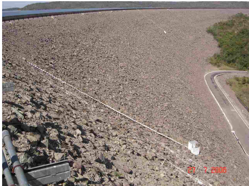
Figura 3.24 – Enrocamento da Barragem de Manso.
