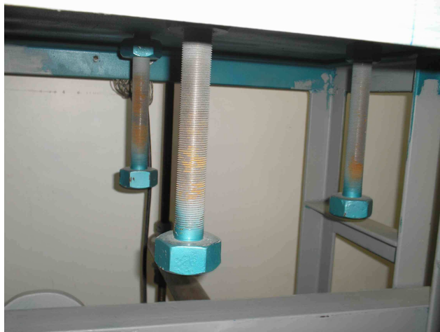
Figura 3.5 - Detalhe dos três parafusos de apoio da base circular.
