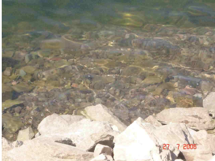
Figura 3.27 – Enrocamento abaixo do nível mínimo do reservatório da Barragem de Manso.
