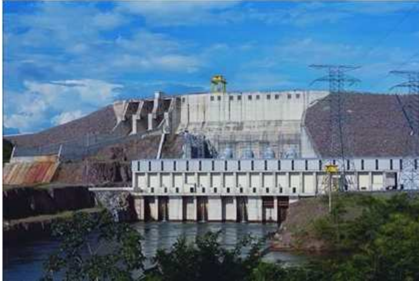
Figura 3.23 - Barragem de Manso, Cuiabá – MT.
