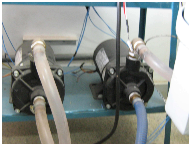
Figura 3.17 – Sistema de bombas utilizado no equipamento.
