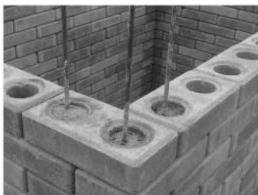
**Figura 2.8 – Execução de coluna grauteada com alvenaria de solo-cimento**
