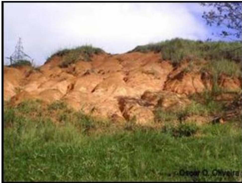
Figura 37: Foto de uma erosão na área de estudo
