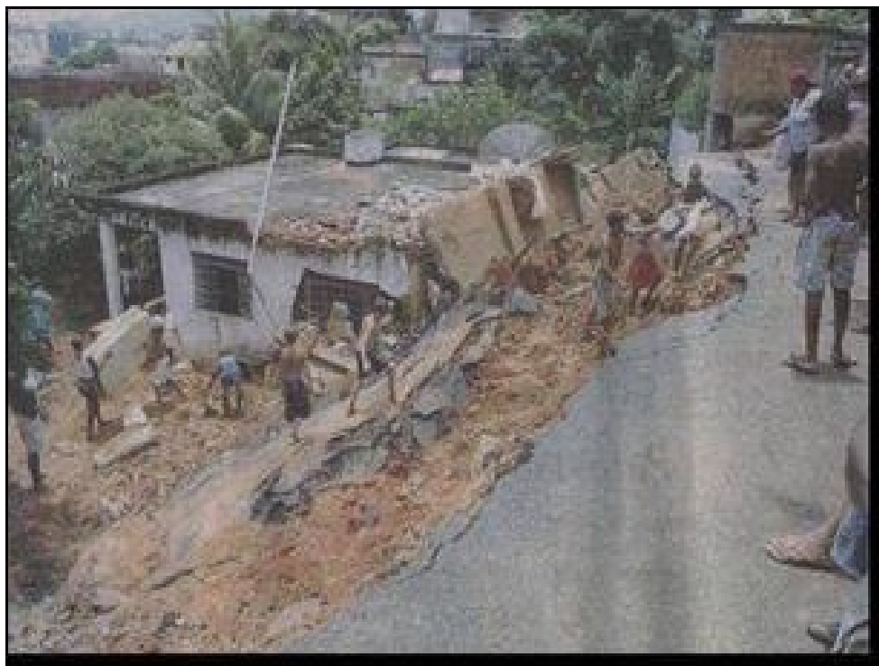
Figura 40: Foto de escorregamento de uma encosta
