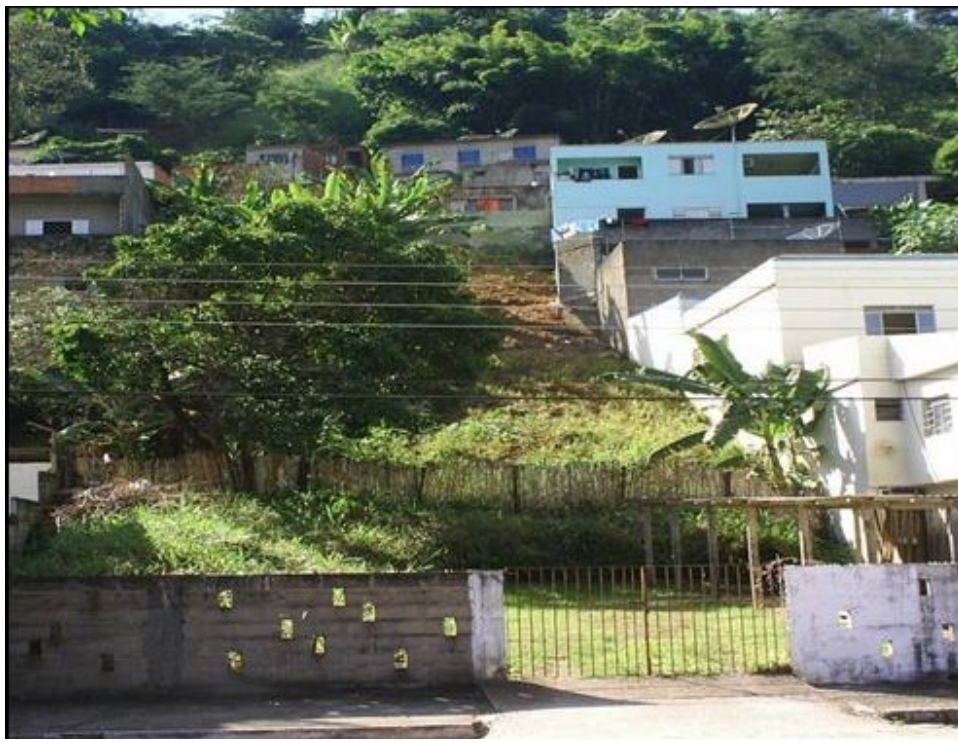
Figura 38: Foto de construção em local de alta declividade
