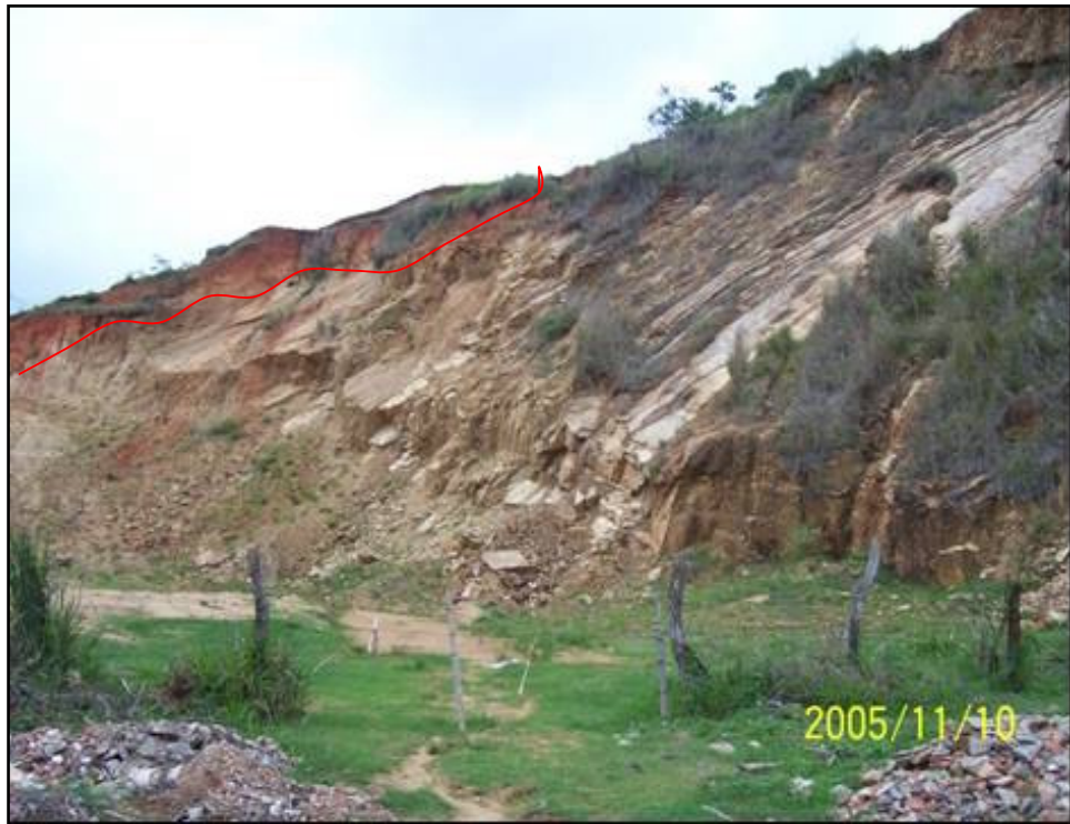
Figura 28: Foto com solo pouco espesso e rocha alterada com estruturas
