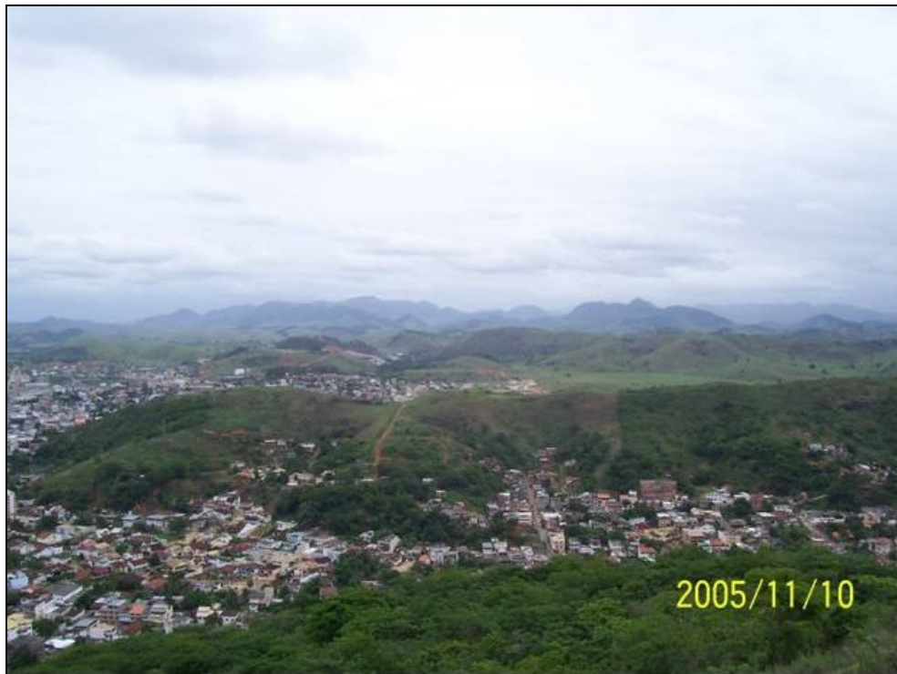
Figura 26: Foto com casas nas partes baixas de uma encosta
