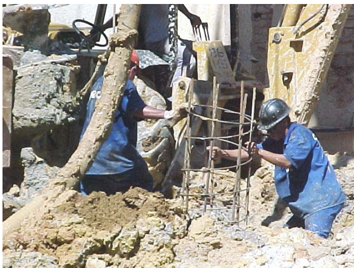
Figura 3. 3 – Colocação da armadura por gravidade em estaca hélice contínua.
