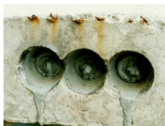
Figura 4.3 – Ancoragem no centro da laje, CAUDURU (2002).
