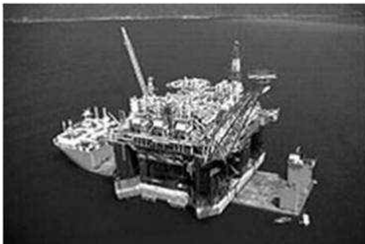
Figura 2.5 – Plataforma semi-submersível (extraída de Kunitaki, 2006)
